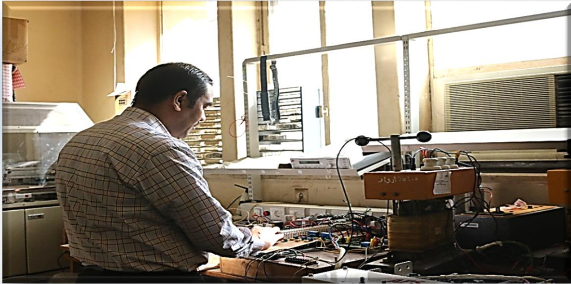
تنفيذ تقنية الملف المحكوم بالثايستور لتحسين معامل القوة Thyristor controlled reactor for power factor improvement
