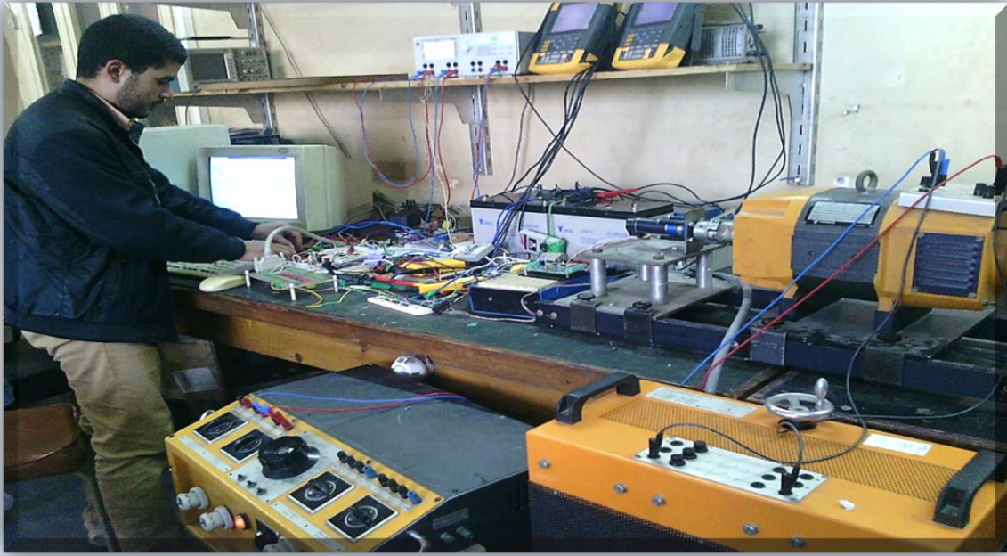
توصيل محرك كهربائي لا تلامسي بنظام خلايا شمسية قائم بذاته باستخدام التقنيات الذكية ليعمل كمضخة مياه
